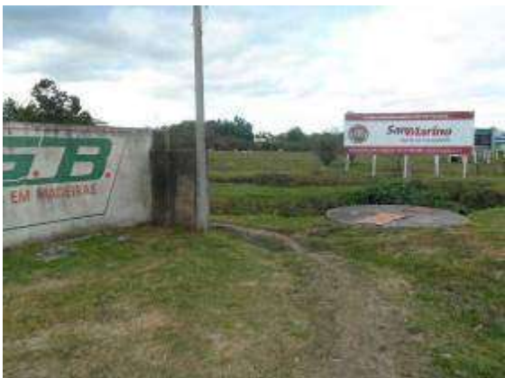
Local da Elevatória Ceval. (Fonte SANEP)
