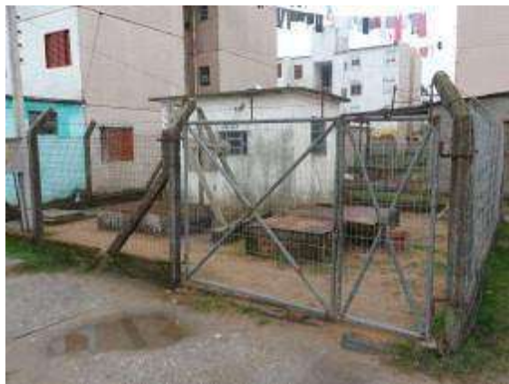
Local da Elevatória Cohab Pestano. (Fonte SANEP)
