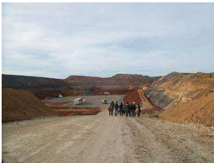
Figura 3.42 – Vista do aterro sanitário Candiota
