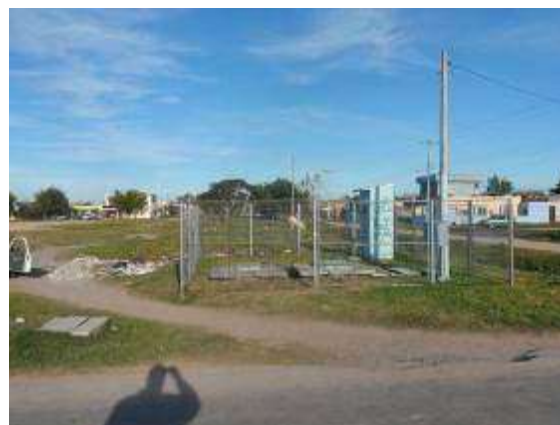
Quadro de comando ELE – Meneghetti. . (Fonte SANEP)
