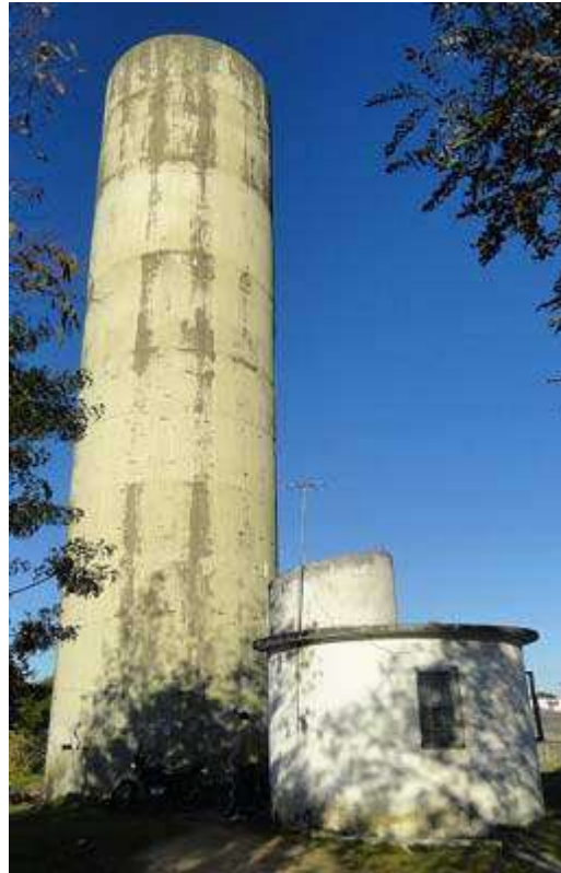
Ilustração 08 – Vista frontal do Reservatório Lindóia.
