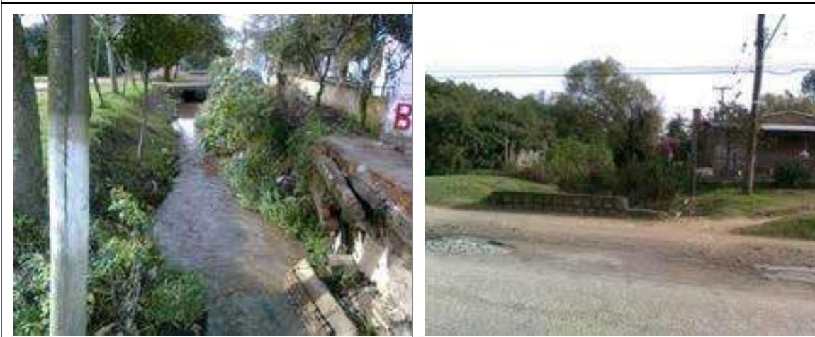
Figura 19: Avenida Domingos de Almeida - Obelisco
