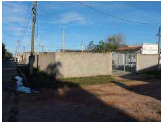
Local da Elevatória Navegantes. (Fonte SANEP)
