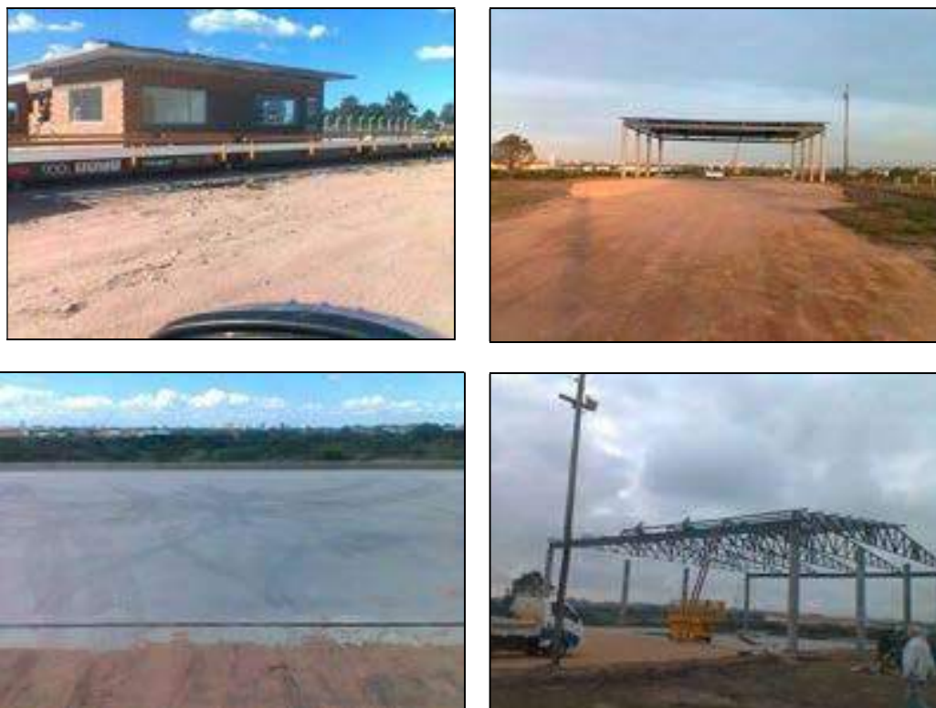
Figuras 3.45, 3.46, 3.47 e 3.48 – Obras de instalação da Estação de Transbordo
