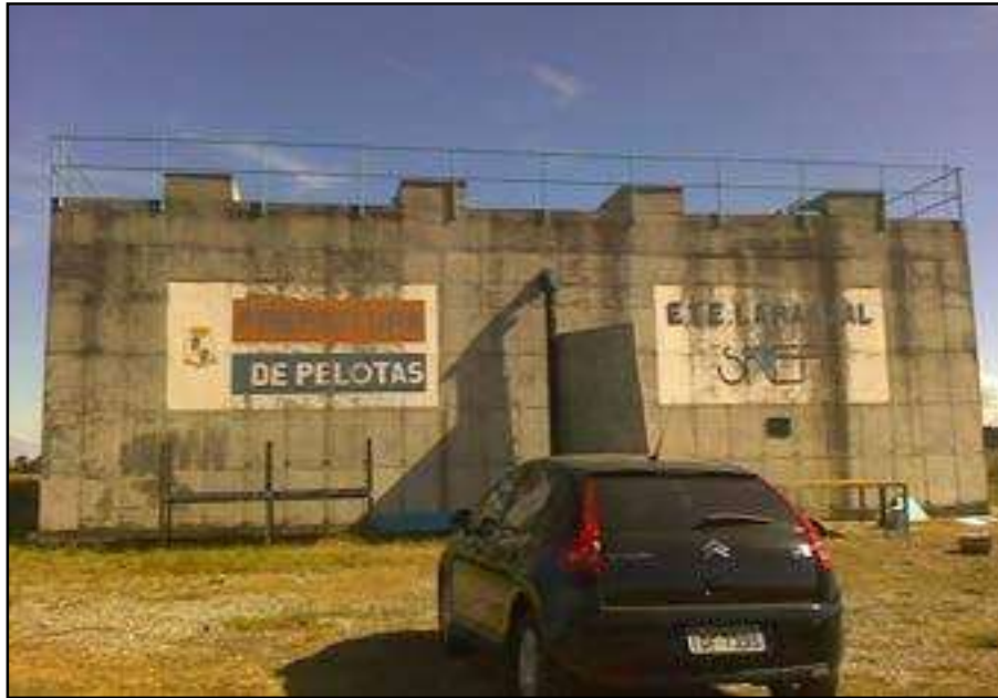
Figura 28 – Reator anaeróbio (Fonte STE)
