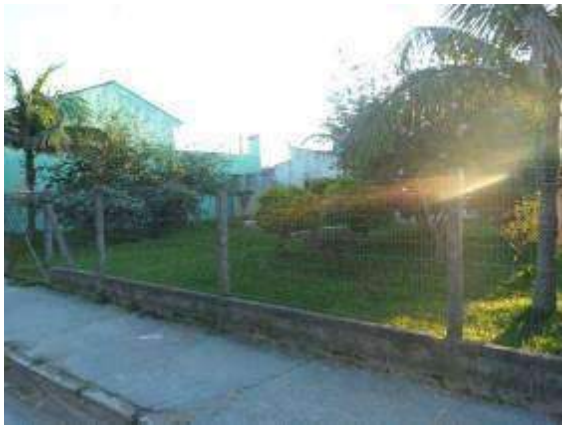
Local da Elevatória Cohab Tablada. (Fonte SANEP)
