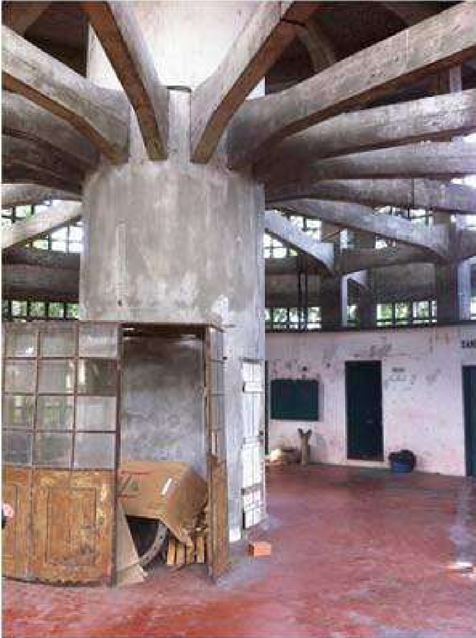
Ilustração 03 – Interior do Reservatório R4.
