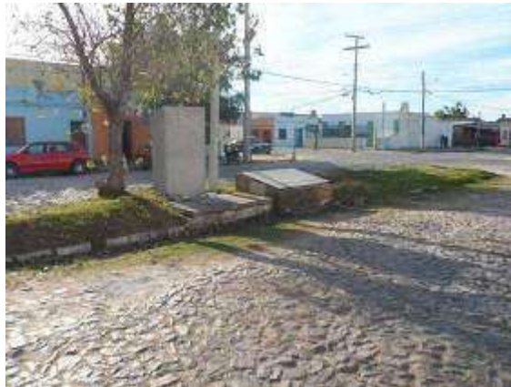
Local da Elevatória Fátima. (Fonte SANEP)
