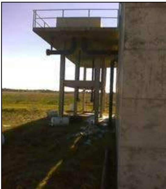
Figura 26 – Desarenador (Fonte STE)
