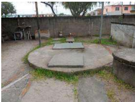
Local da Elevatória Guabiroba . (Fonte SANEP)
