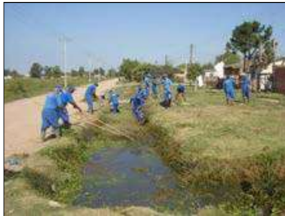
Figura 3.33 – Limpeza de valetas
