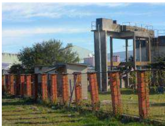
Entrada e visualização da ETE e ELE – Jardim das Tradições. (Fonte SANEP)
