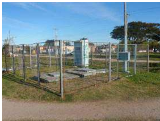
Local da Elevatória Meneghetti. (Fonte SANEP).
