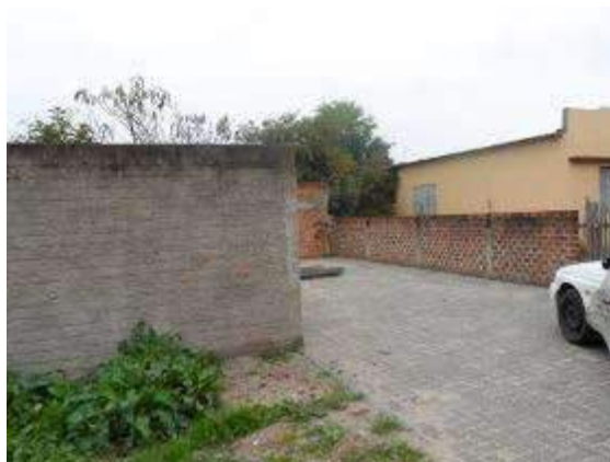
Entrada ELE – Toussaint (desativada). (Fonte SANEP)
