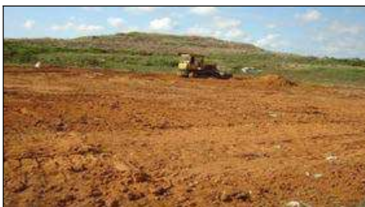
Figura 3.1 – Obras de terraplenagem e impermeabilização da base do aterro
