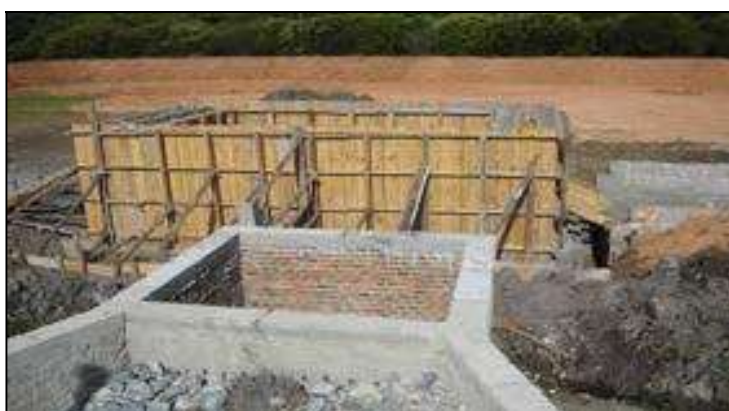
Figura 3.2 – Construção de caixa de passagem e filtro anaeróbico para o sistema de tratamento de lixiviado
