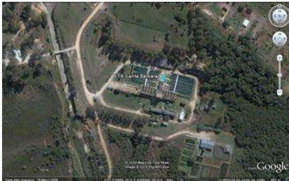
Ilustração 34 – Vista da ETA Santa Barbara
