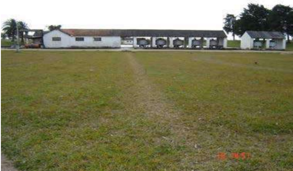
Ilustração 28 - Local do reservatório enterrado com 8.000m 3
