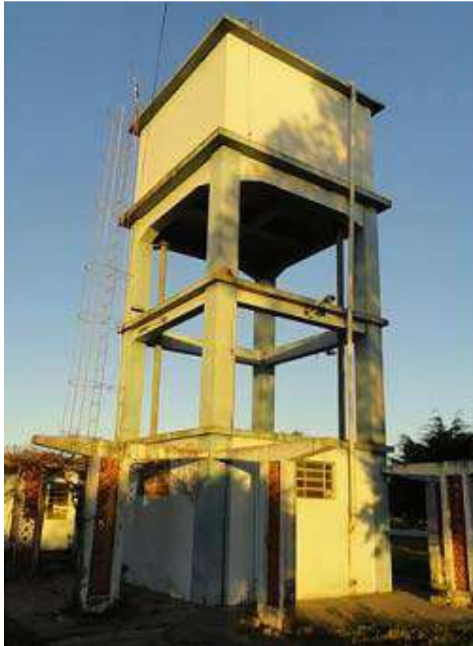
Ilustração 013 – Vista frontal do Reservatório localizado no Balneário dos Prazeres.
