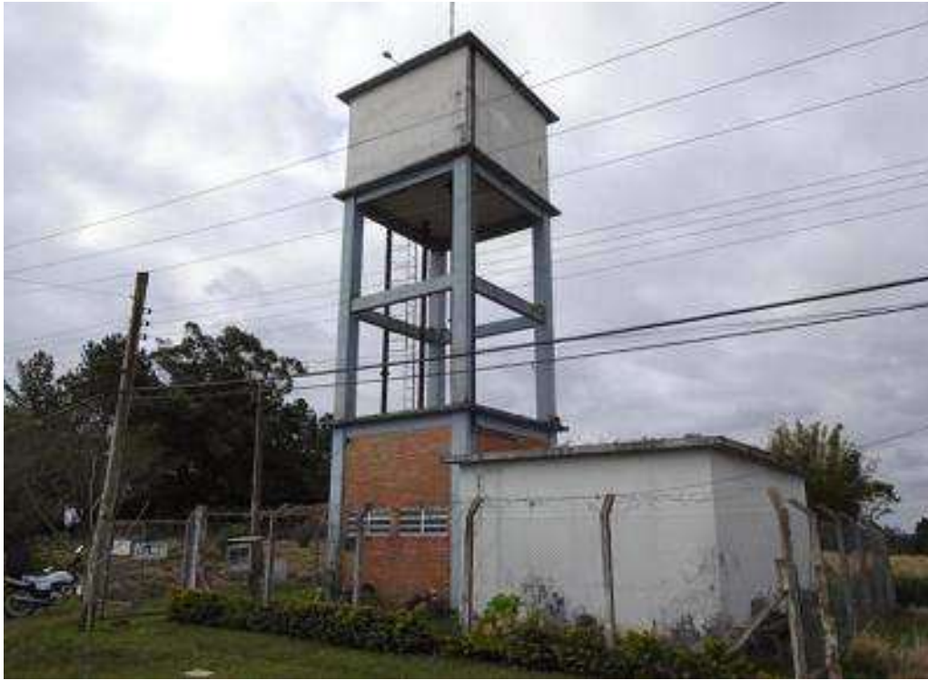
Ilustração 019 – Vista do Reservatório MB-2, localizado na Colônia Monte Bonito.
