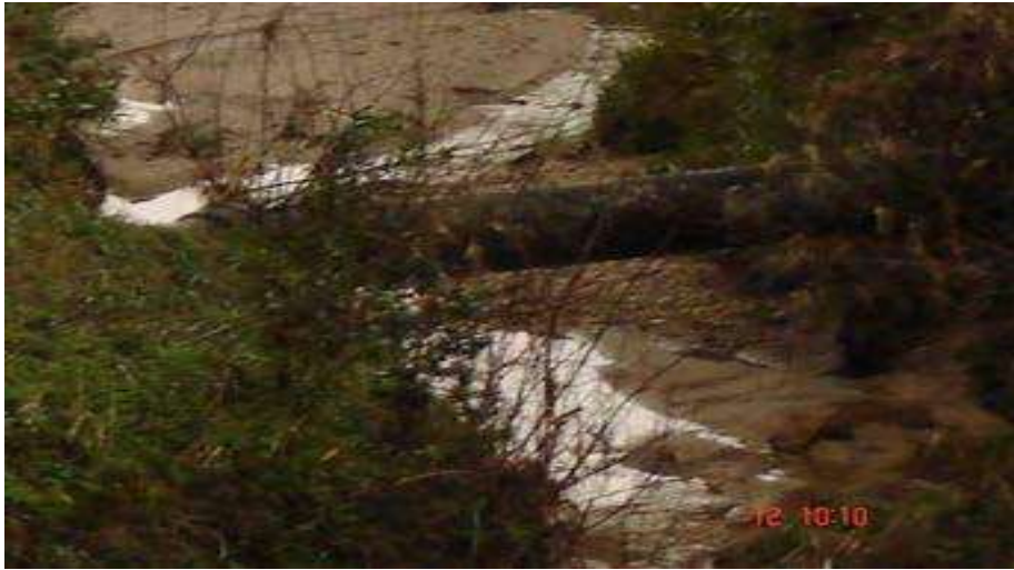
Ilustração 12 - Adutora de 450 mm cruzando o canal extravasor da barragem
