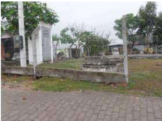
Local da Elevatória Ceval. (Fonte SANEP)
