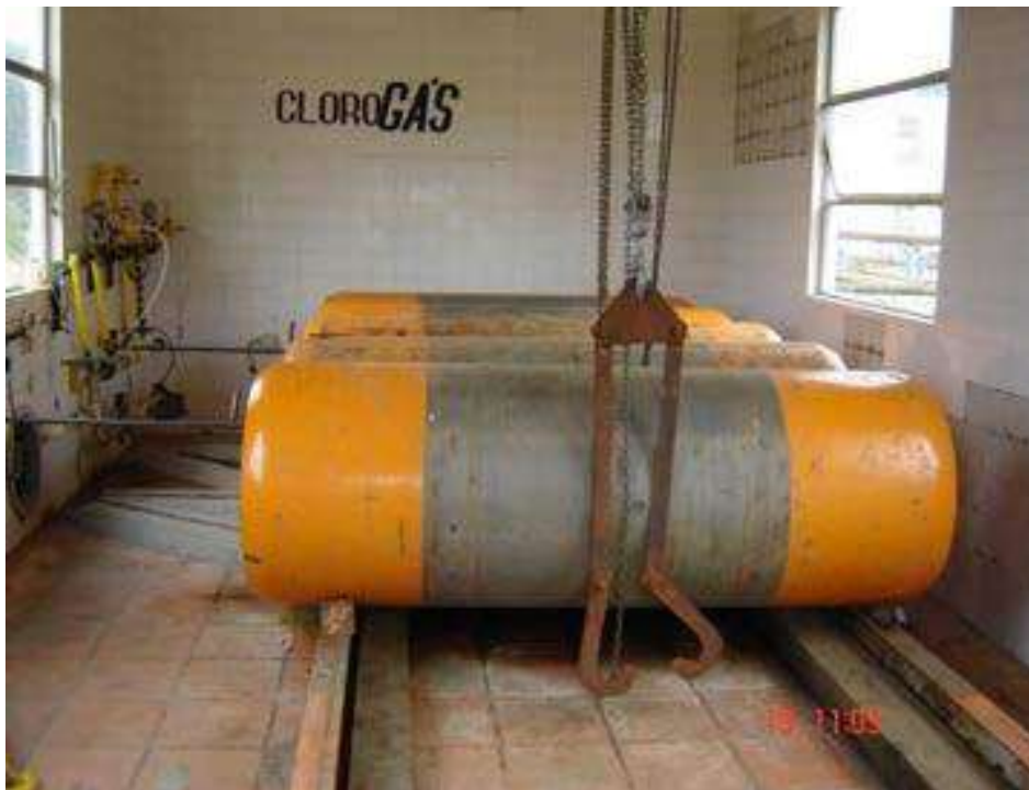
Ilustração 45 - Cilindros de cloro
