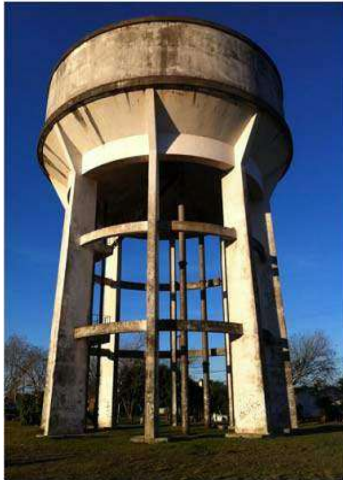
Ilustração 010 – Vista frontal do Reservatório R10.
