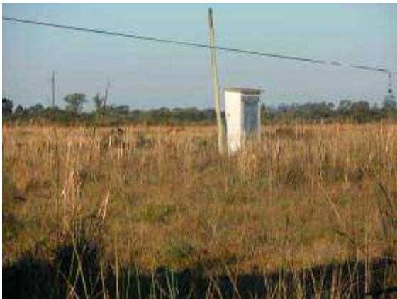
Local da Elevatória Ceval. (Fonte SANEP)
