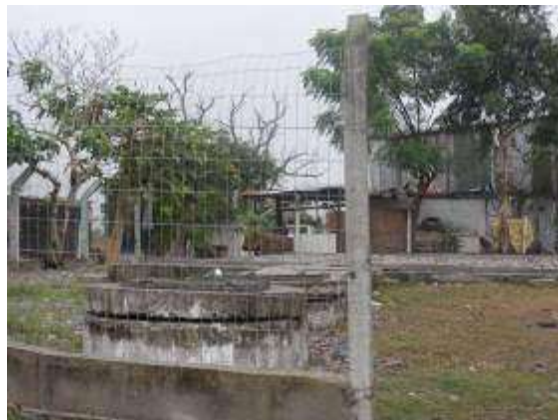
Entrada da ELE – Ceval. (Fonte SANEP)
