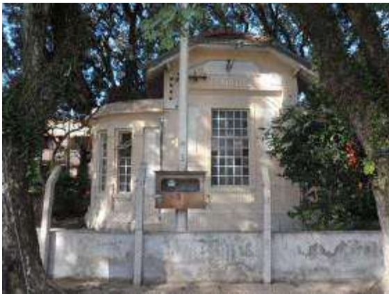
Elevatória Saldanha Marinho US-II. (Fonte SANEP)
