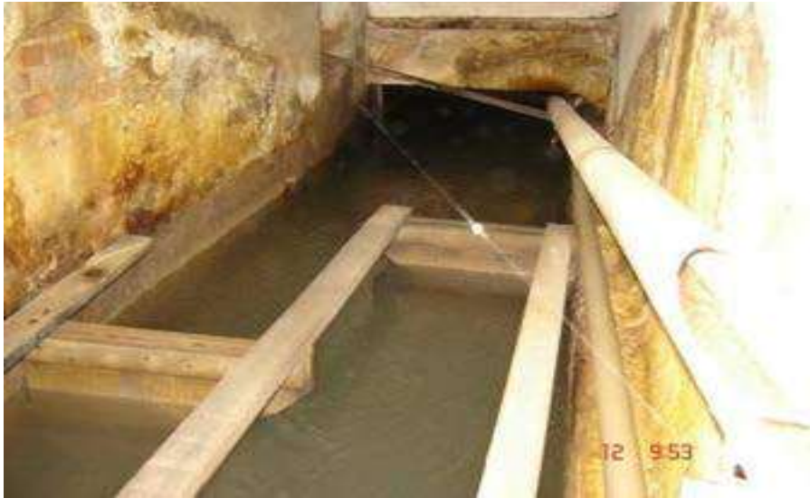
Ilustração 6 – Calha de mistura com chicanas
