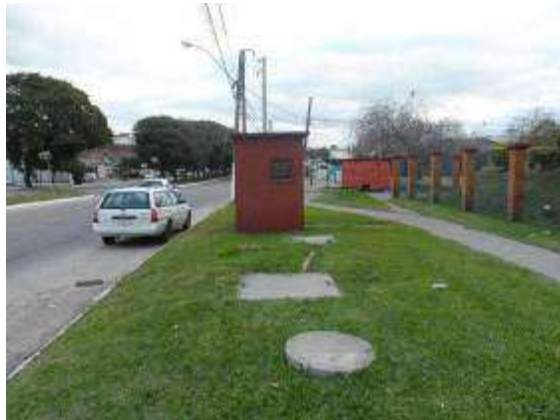
Local da Elevatória Ferreira Viana. (Fonte SANEP)
