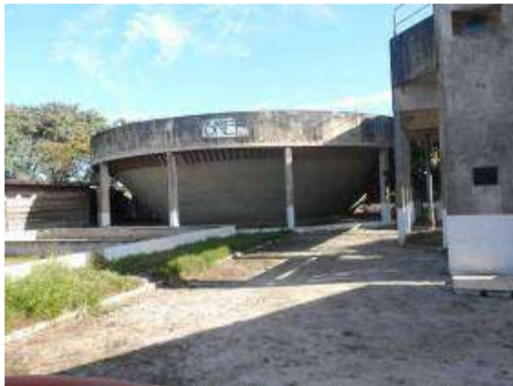
Elevatória US-III - RALF. (Fonte SANEP)
