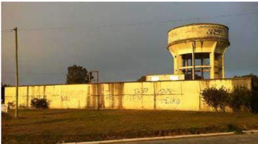
Ilustração 015– Vista frontal do Reservatório localizado no Balneário Santo Antônio.
