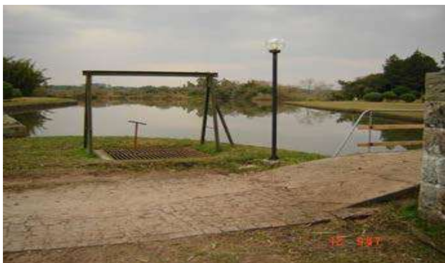
Ilustração 3 - Tomada de água bruta ETA Moreira
