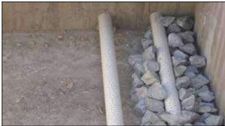
Figura 3.4 – Detalhe do filtro anaeróbio em fase construtiva. No detalhe observam-se os tubos perfurados
