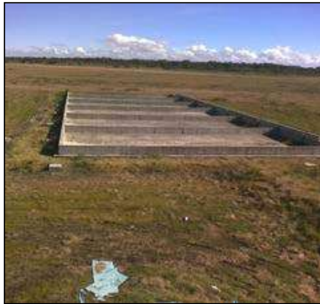
Figura 33 - Leitões de secagem de lodo (Fonte STE)
