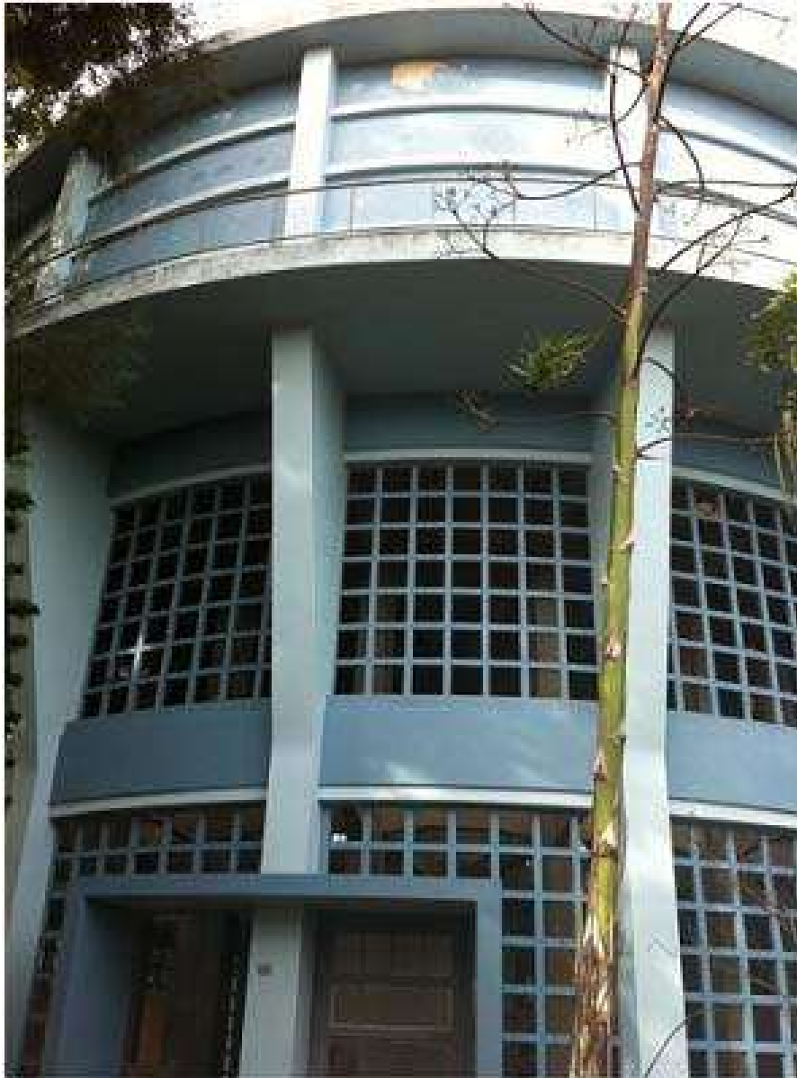
Ilustração 02 – Vista frontal do Reservatório R4.
