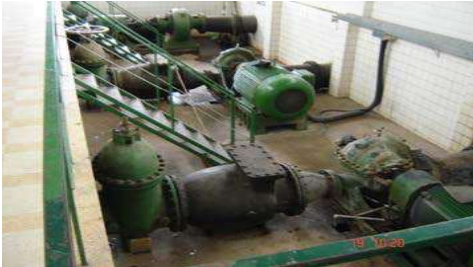
Ilustração 48 - Vista parcial da casa de bombas
