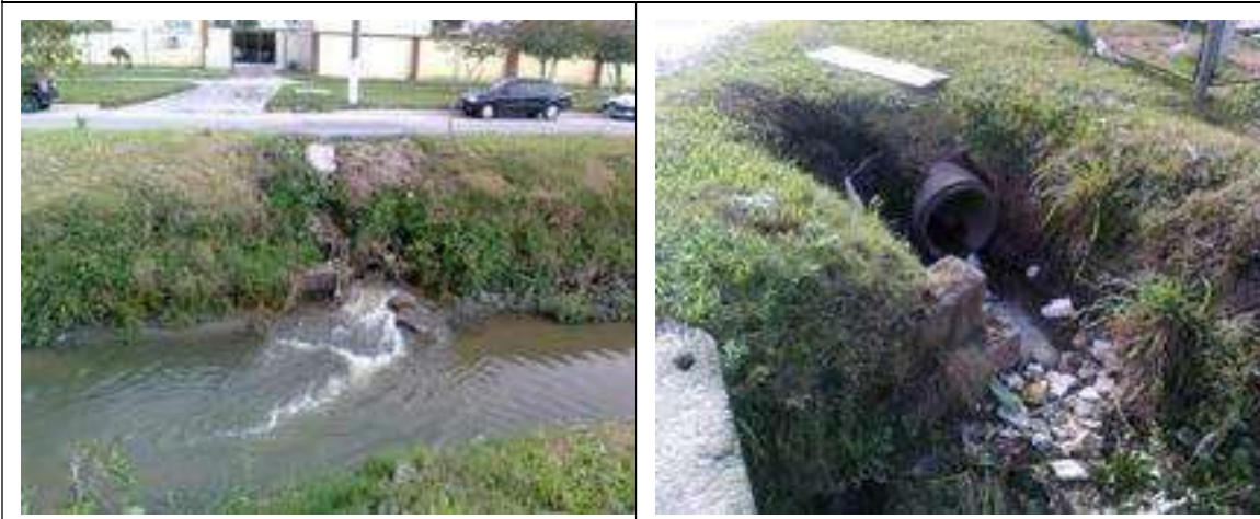
Figura 12: Microdrenagem descarregando na macrodrenagem
