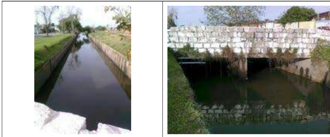
Figura 14: Canal do Arroio Pepino - Avenida Juscelino Kubitschek com General Neto
