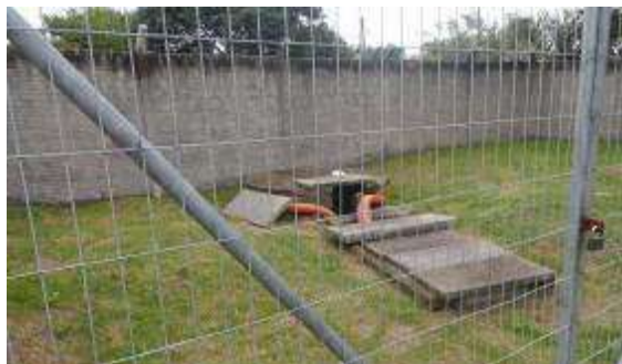
Local da Elevatória Cohab Lindóia. (Fonte SANEP)
