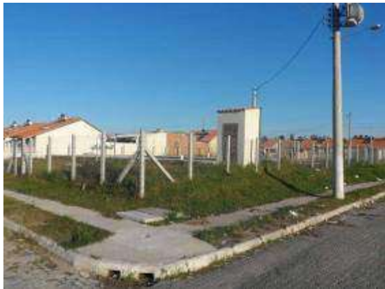
Local da Elevatória Eldorado. (Fonte SANEP)
