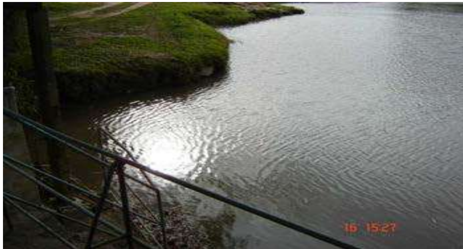
Ilustração 16 - Tomada de água Arroio Pelotas
