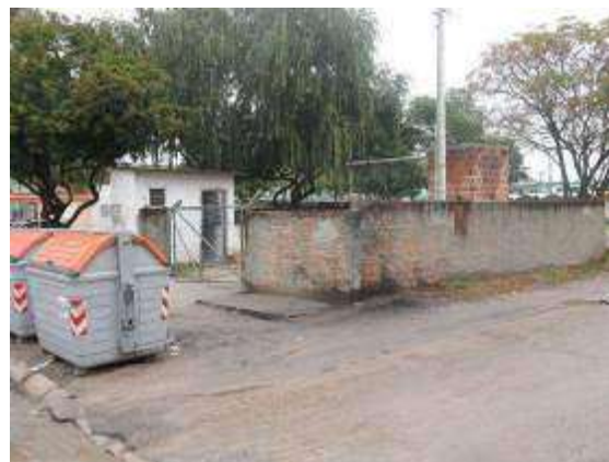
Quadro de comando ELE – Guabiroba. (Fonte SANEP)
