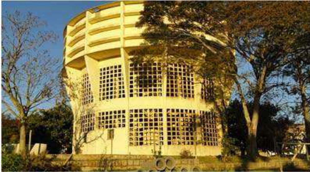
Ilustração 011 – Vista geral do Reservatório R-3.
