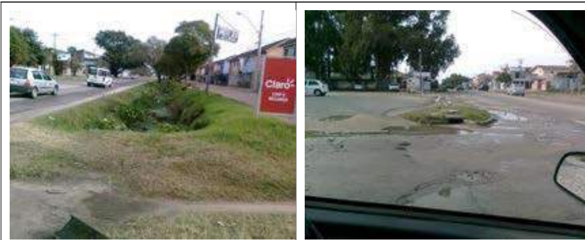
Figura 23: Avenida Salgado Filho, ponto crítico de alagamento.
