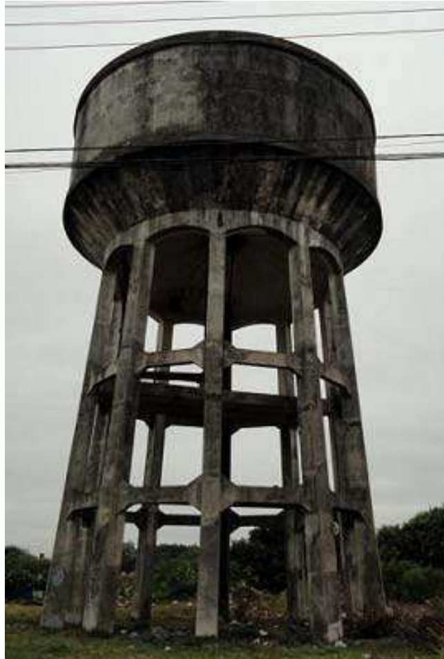
Ilustração 05 – Vista frontal do Reservatório R7.
