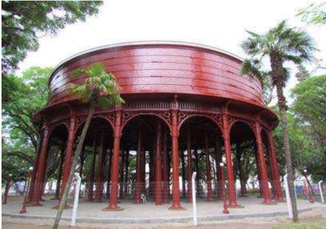
Ilustração 05 – Vista frontal do Reservatório R1.
