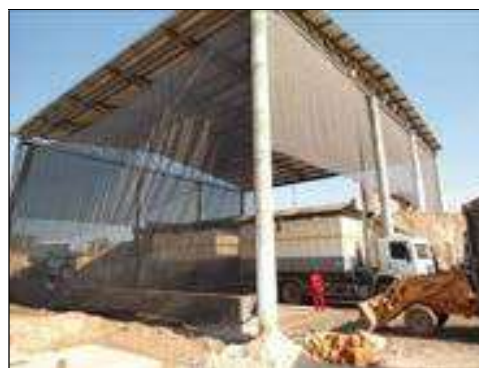
Figura 5.18 – Vista do transbordo
