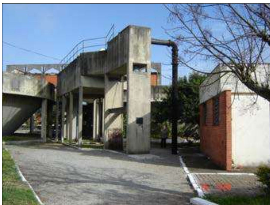
Figura 15 - Vista da estrutura de entrada (desarenador e Calha Parshall), com os dois reatores ao fundo. (Fonte STE)
