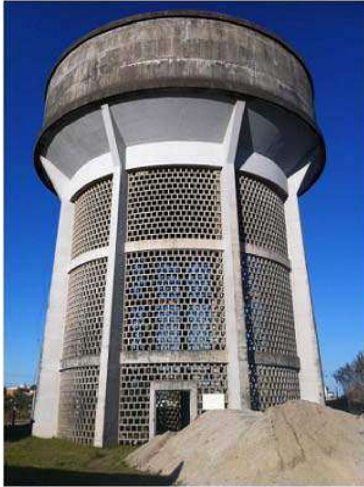
Ilustração 04 – Vista frontal do Reservatório R8.
