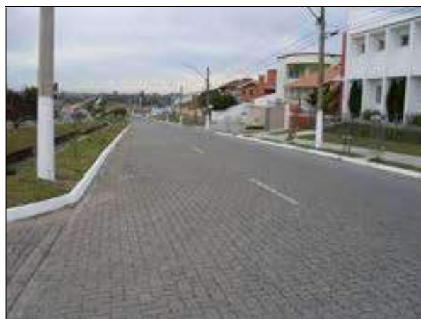
Figura 3.31 – Meio-fio após serviço de pintura
