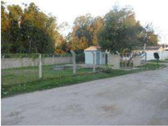
Local da Elevatória Cohab Fragata. (Fonte SANEP)
