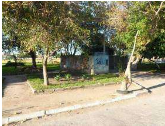
Local da Elevatória Ambrósio Perret. (Fonte SANEP)
