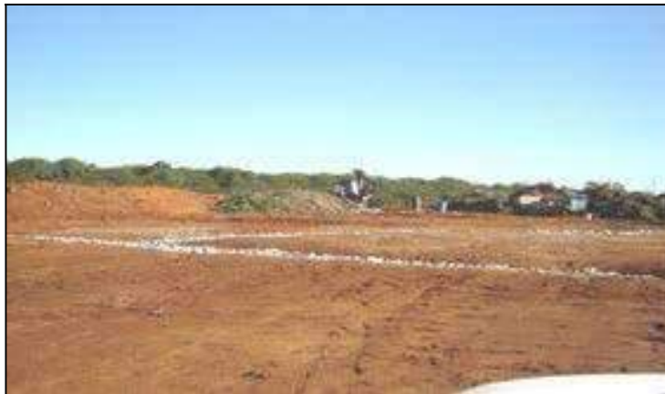
Foto 3.5 – Lançamento do sistema de drenagem de chorume
